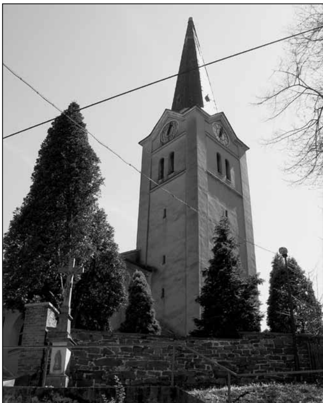
Hlavní přístup ke kostelu od komunikace procházející obcí, při pohledech z této strany na kostel nelze přehlédnout nevzhledné dráty.
