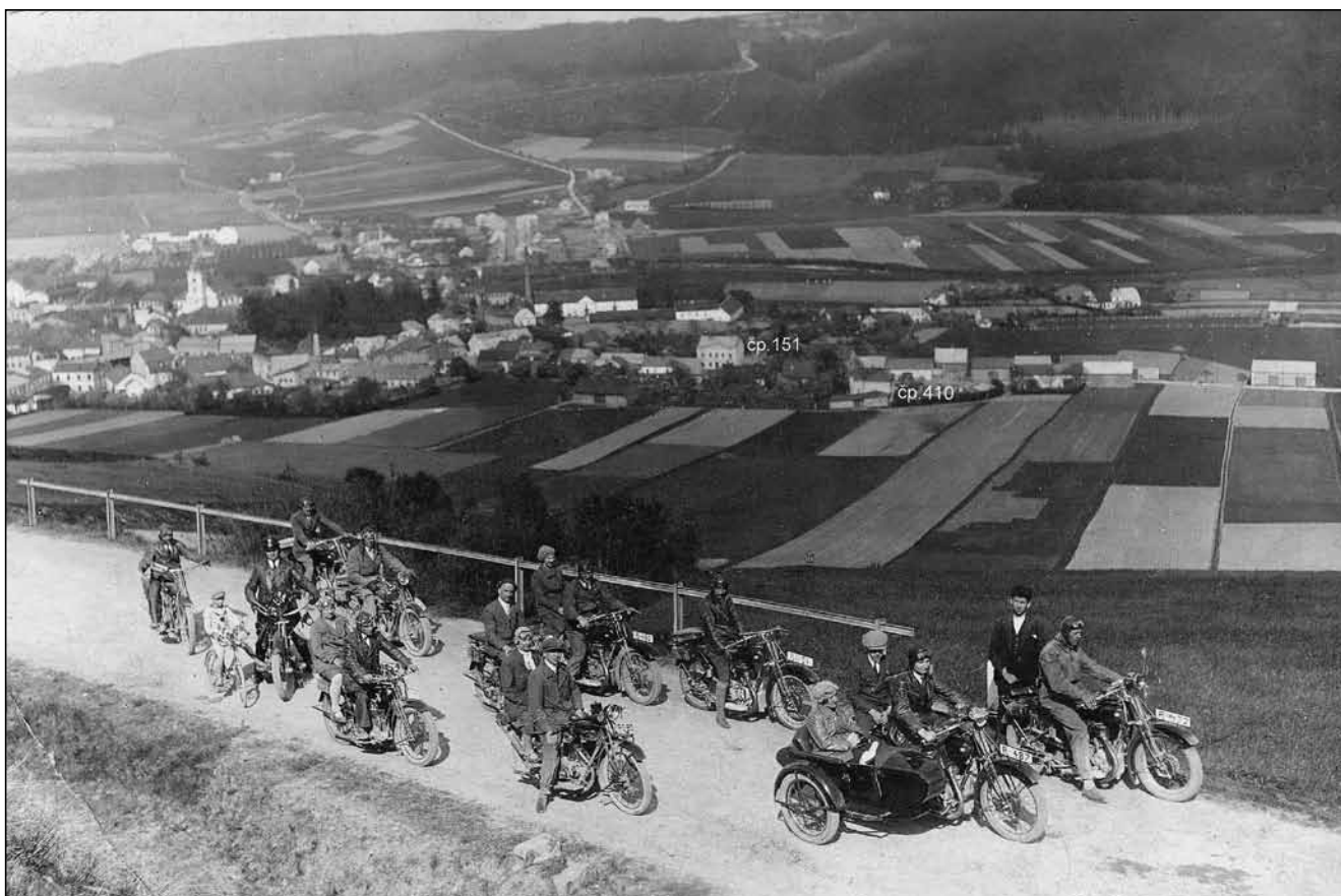
Třetí serpentina horské silnice Odrá–Veselí (u bývalé lyžařské louky), r. 1926. Pod Veselským kopcem jsou vidět dva vyšší domy na Hranické ulici, dům Waschkovy rodiny (čp. 151) a vedle napravo dům Rudolfa a Aloisie Lipowských (čp. 410). V pozadí se vine horská silnice Odrá–Pohoř. Zdroj: Archiv Emila a Zdenka Mateiciucových.
