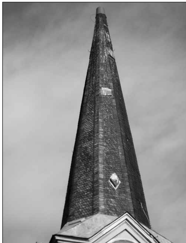
Skladba břidlice na střeše věže kostela, detail zaplechování původních kosodélných větracích okének.
