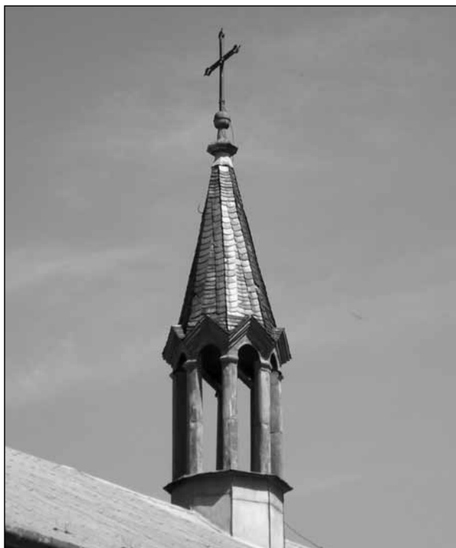
Detail sanktusníku se skladbou střešní krytiny z břidlice.
