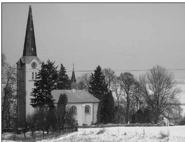
Celkový pohled na kostel při zahájení rekonstrukce prováděné v r. 2012 (Foto Petr Kozár).
