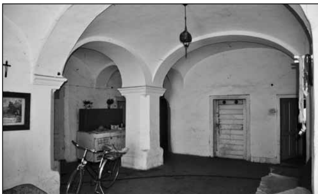
Vstupní síň hlavní budovy fojtství zaklenuté plackami na pasech a dosedající na mohutný středový pilíř s vysokým soklem a postranní polopilíře bočního zdiva.
