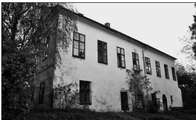
Hlavní budova – boční západní fasáda fojtství, pohled od zahrady.
