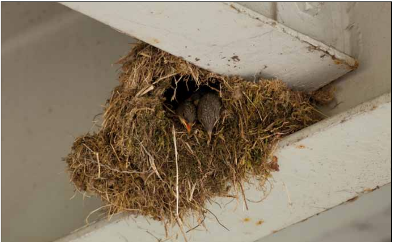
Hnízdo skorců s mláďaty pod mostní konstrukcí.
